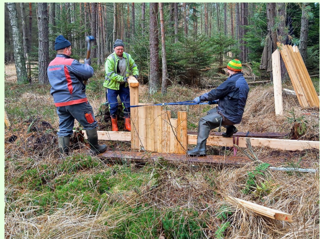
Abbildung 5: Einbau von Holzspundwänden in einem Waldviertler Moor.
